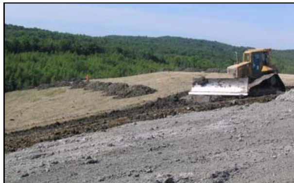
Étalement de la couche protectrice sur la couche peu perméable.
