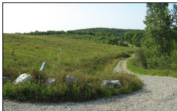
Recouvrement final du site d'enfouissement après la première semence
